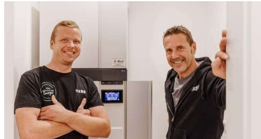
Effizienzpartner Thomas Merkl (rechts) und sein Mitarbeiter Maximilian Eisen vor der platzsparend installierten NIBE S735 – kompakte Technik, stolz präsentiert im historischen Bestand.
