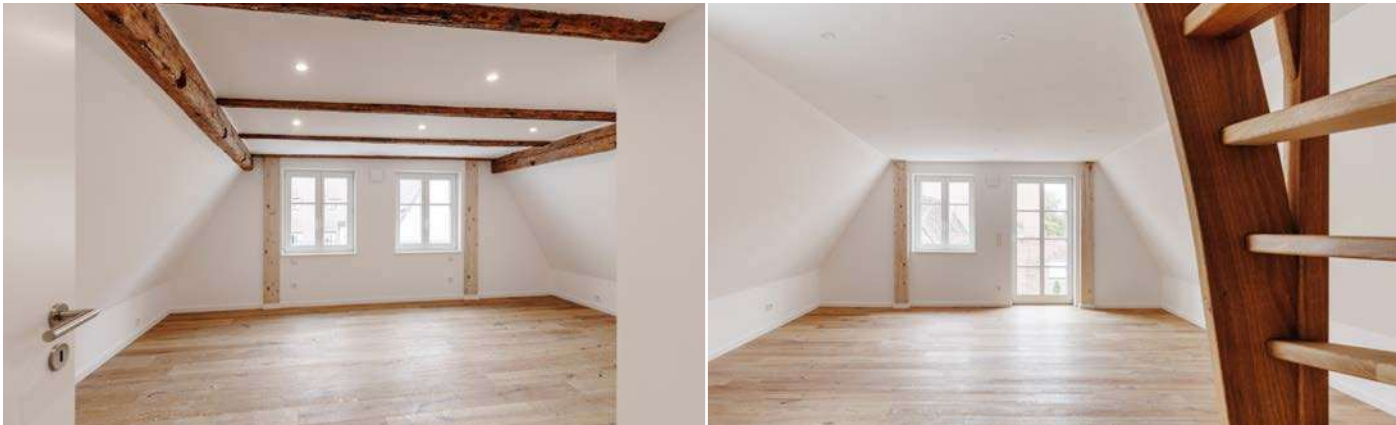
Helle, behagliche Räume mit freigelegten Balken, Trittschalldämmung und angepasster Wärmeverteilung – je nach Etage mit Fußboden- oder Deckenheizung, perfekt integriert in das historische Gebäude.
